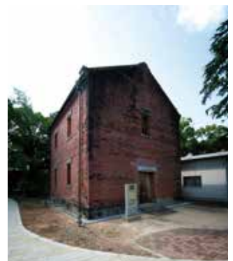
レンガ倉庫(明治40年2月竣工)
