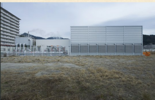
発電所は小浜海岸のすぐそばに設置されています。
