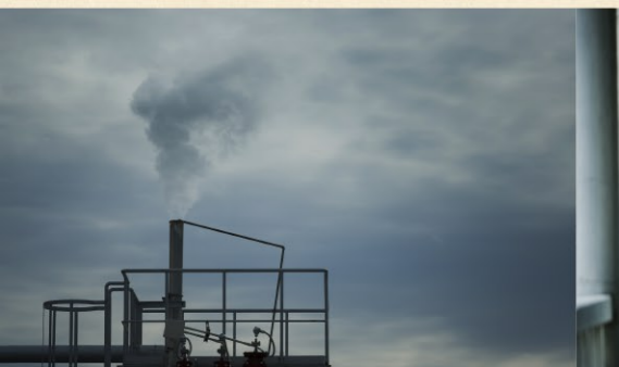
発電所の煙突からは常に大量の蒸気が。
