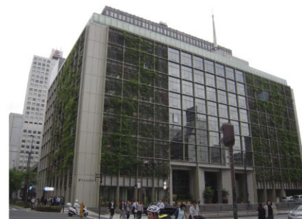
壁面緑化が施されたオフィスビル パソナ本部ビル（東京都中央区）には、エネルギー消費を減らし、道行く人の目を楽ませるために、フジ・バラ・果樹などを用いた壁面緑化が施されている。
