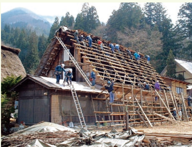
30〜50年に一度行われる茅葺き屋根の葺き替え。かつては「結」とよばれる住民相互の無償労働で行われていたが、現在は地元の専門業者に依頼することも多い。
