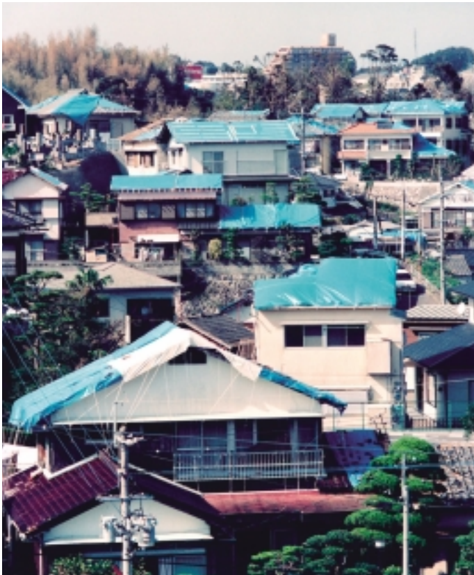
写真3 1991年9月27日の台風第19号後の長崎市内の斜面地の住宅 瓦が飛ばされた家屋では、応急対策として青いビニールシートが屋根に張られた光景が多数見受けられた。阪神・淡路大震災後の阪神間の住宅地や福岡県西方沖地震後の玄界島斜面地でもこのような光景が見られた。(長崎新聞社提供)
