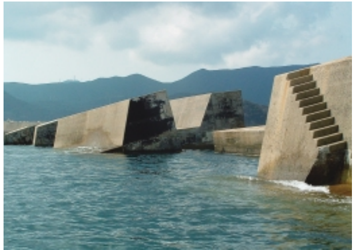
写真1・上 2005年9月6日の台風第14号による防波堤の被害 (長崎県土木部港湾課提供)
