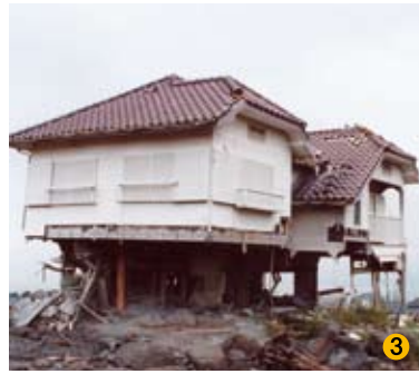
土石流によって被災した家屋(安中地区) 1993年9月10日撮影 (島原市役所 杉本伸一氏提供)
