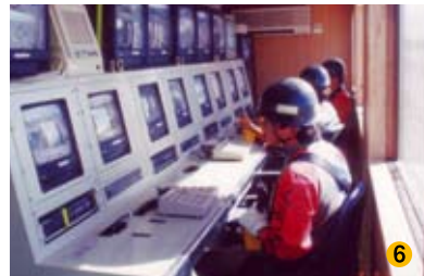
無人化施工による警戒区域内の除石作業状況と操作室 1994年4月11日撮影 (元雲仙復興事務所長 松井宗廣氏提供)
