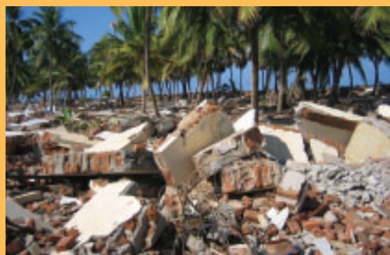
海岸線から約1kmの被害は特にひどく、倒壊した建物の破片で埋め尽くされた
